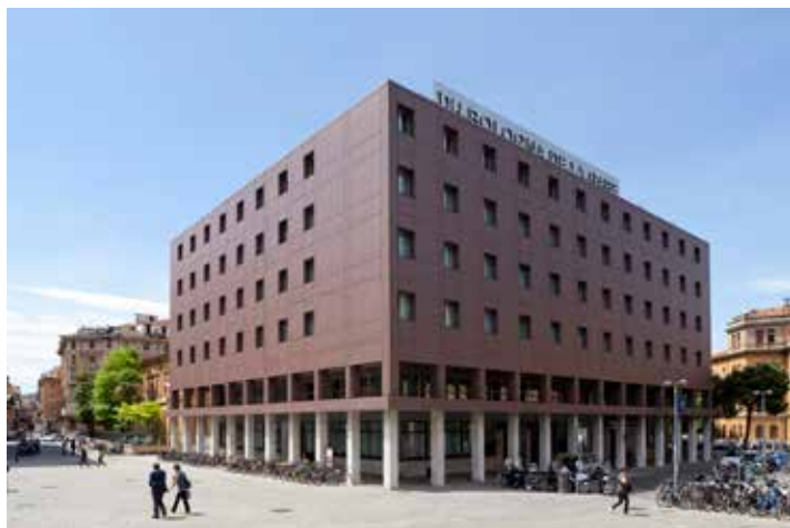
Hotel, Bologna (Italia) - Progettazione: Gagliardi-Vincenzi Studio Associato di ingegneria Copyright foto: Pier Mario Ruggeri
