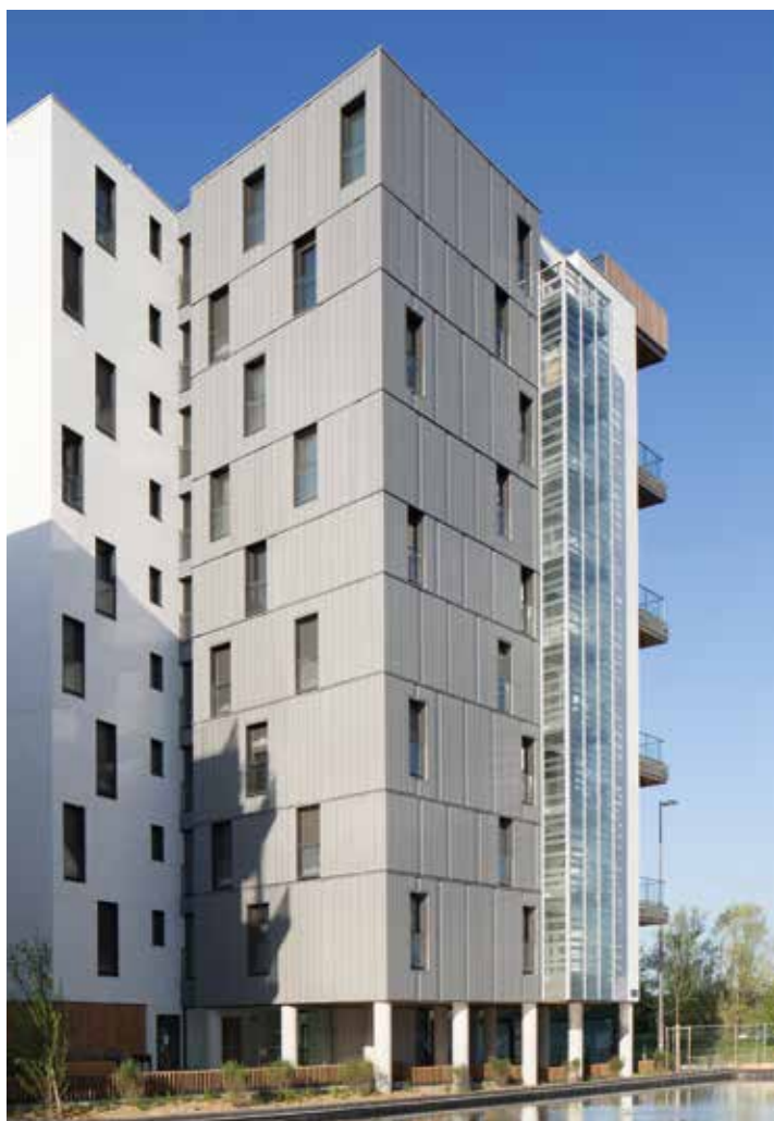
Complesso residenziale Jules Verne, éco quartier Ginko, Bordeaux (Francia) - Architetto : Brochet Pueyo Lajus Installazione : Moriceau
