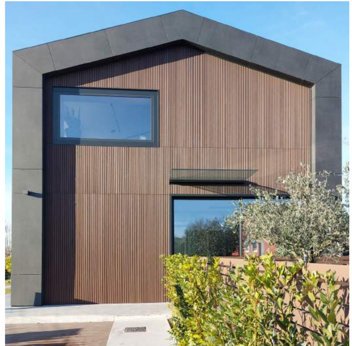
Edificio direzionale, Pomezia (RM)
